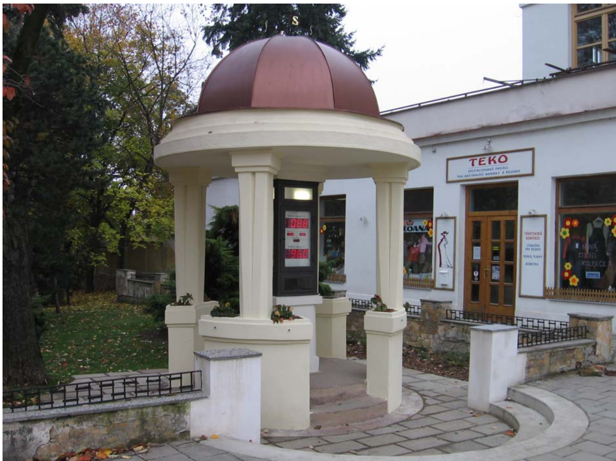
Obr. 5 Celkový pohled zrekonstruovaný altánek
